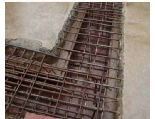
后浇带浇筑封闭前基层清理及凿毛
