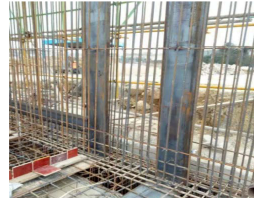
外墙后浇带钢板止水带安装
